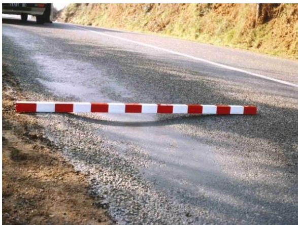
**Problématique :** L'orniérage, dû aux déformations permanentes des matériaux non traités, est l'un des principaux modes de dégradation des chaussées souples à faible trafic.
