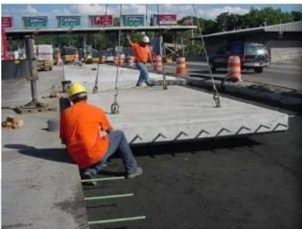
Réparation de dalles fissurées par fers de liaison
