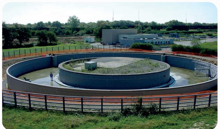
Cuvelage pour le contrôle du niveau de la nappe phréatique © LAMES
