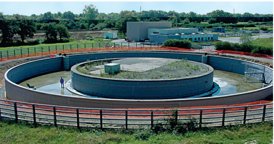
Cuvelage pour la reconstitution de la nappe phréatique
